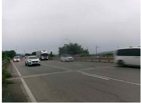
교량 상부 전경
