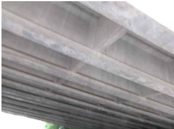
바닥판 하면 및 거더 전경
