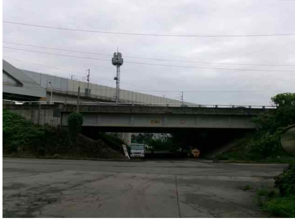
교량 측면 전경
